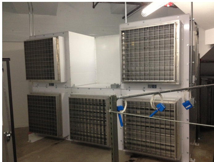
5 fan cell installation.
